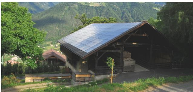
Si tratta di soluzioni tecnologiche che mimetizzano le celle fotovoltaiche negli elementi di copertura in modo da limitarne la visibilità e mitigarne l'impatto estetico-percettivo, a fronte del beneficio in termini di produzione di energia elettrica *in situ*.
