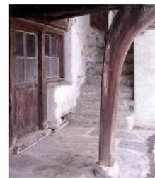
In molti casi le dimensioni delle aperture delle stalle al piano terreno differiscono a seconda degli animali (ovini o bovini) ospitati, con larghezze del vano porta variabili tra gli 80 ed i 90 cm ed altezze pari a 150÷180 cm.
