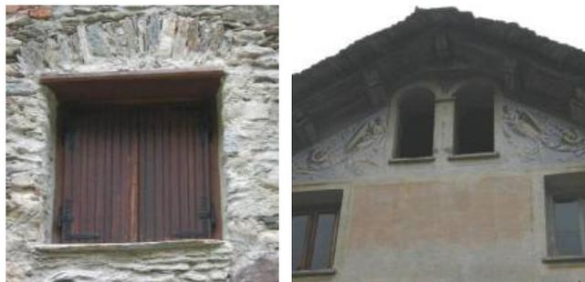
I serramenti delle finestre sono tradizionalmente in legno normalmente a due battenti, con due o tre specchiature, perlopiù quadrate, per ciascuna anta in funzione dell'altezza dell'apertura. Gli infissi sono realizzati in legno, con elementi a sezione ridotta connessi ad incastro, mentre i vetri sono fissati al telaio mobile con mastice o listelli chiodati. Persiane o grandi ante cieche all'esterno, più raramente scuri interni, assicurano l'oscuramento e un'ulteriore barriera al freddo.
