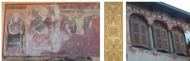
Parimenti evidenti fenomeni di carbonatazione e di ossidazione della pietra, nonché radicamento di licheni e vegetazione infestante nelle sconnessure tra i conci od in corrispondenza delle zone attaccate dal degrado. Molto spesso un degrado fisico-chimico interessa anche i pigmenti utilizzati per la realizzazione di affreschi, dettagli decorativi e facciate *picthae*.
